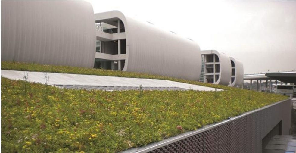
Fig. 4- Malpensa - Milano, copertura verde
