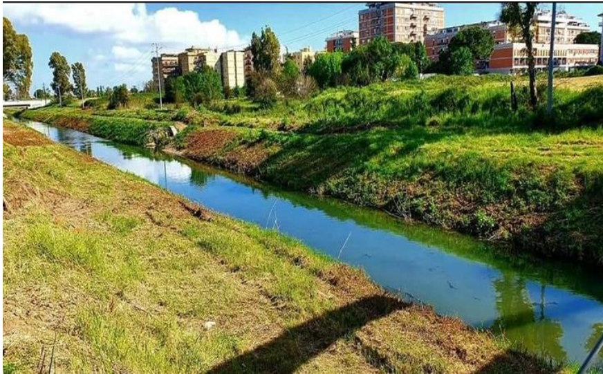
Fig. 2 - Soluzioni di sistemazione degli alvei ottenuti attraverso assetti naturalistici delle aree di golena.
