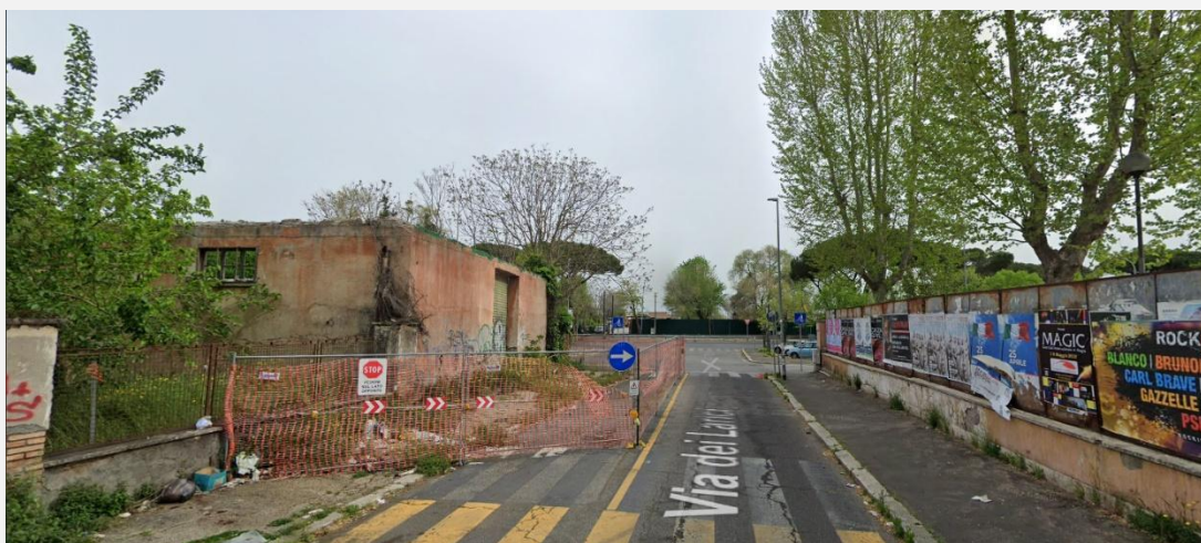
Il Capannone crollato lungo Via dei Larici
