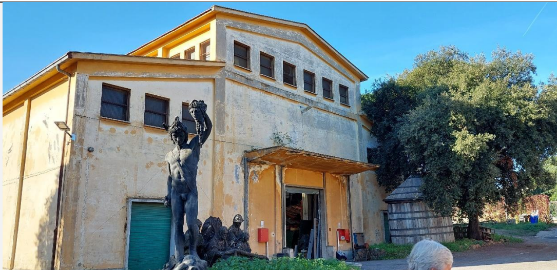
Il terzo capannone grande all'interno
