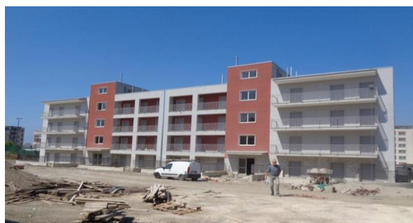
Fig. 2 Intervento in corso di realizzazione al luglio 2018
